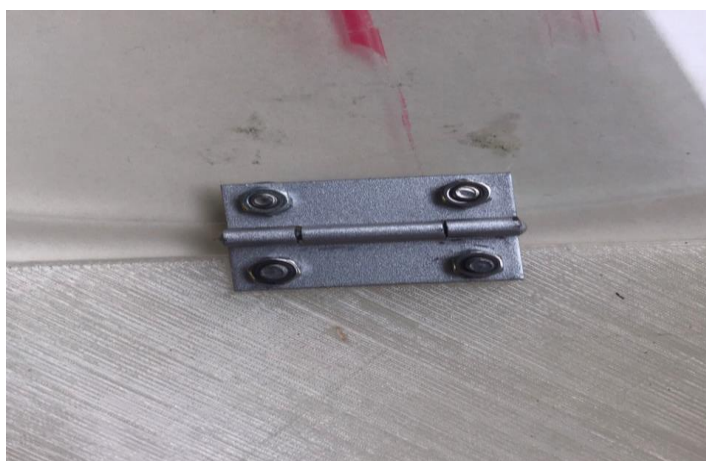
図 3 ダンパー接続部
